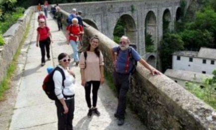
(130° - Escursione acquedotto storico di Genova)
